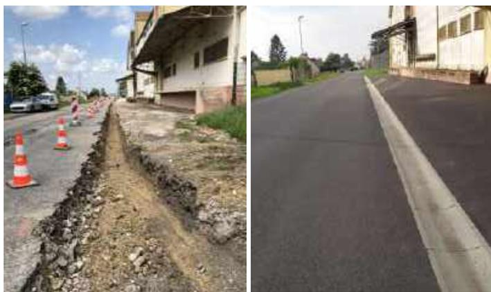
Rue Maisonneuve (de la rue de la Poterne au stade de foot), Reprise de la voirie en enrobé (partie voie communale prise en charge par la Mairie) avec la pose d'un caniveau en rive de la partie des quais de la coopérative (partie quai prise en charge par la coopérative). Le montant des travaux du caniveau et pose des regards de visite a été pris en charge entre la mairie et la coopérative.
