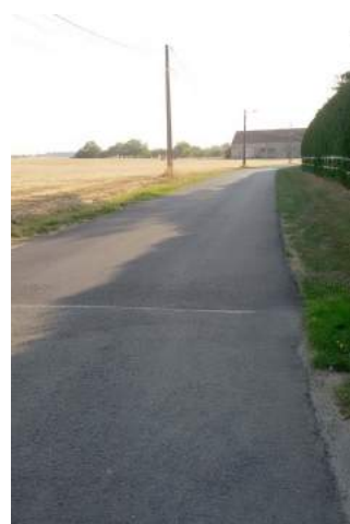
Rue des Murs – Reprise en enrobé
