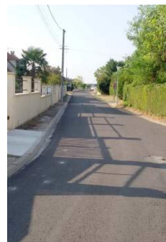
Rue des Cerisiers – Reprise en Enrobé Coulé à Froid (ECF)
