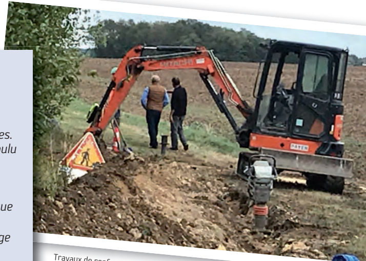
Travaux de renforcement des canalisations.
